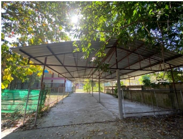
ภาพ ๖ โรงจอดรถจักรยานยนต์
